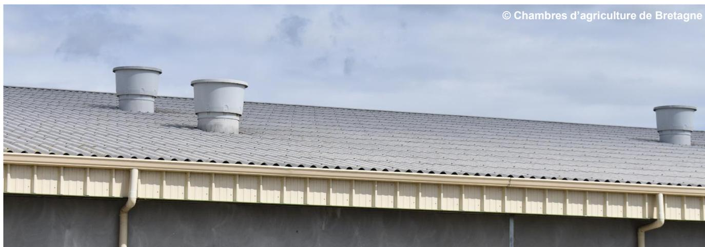
60 à 80 % de l'extraction de l'air se fait par extraction haute et pompage dans la masse
