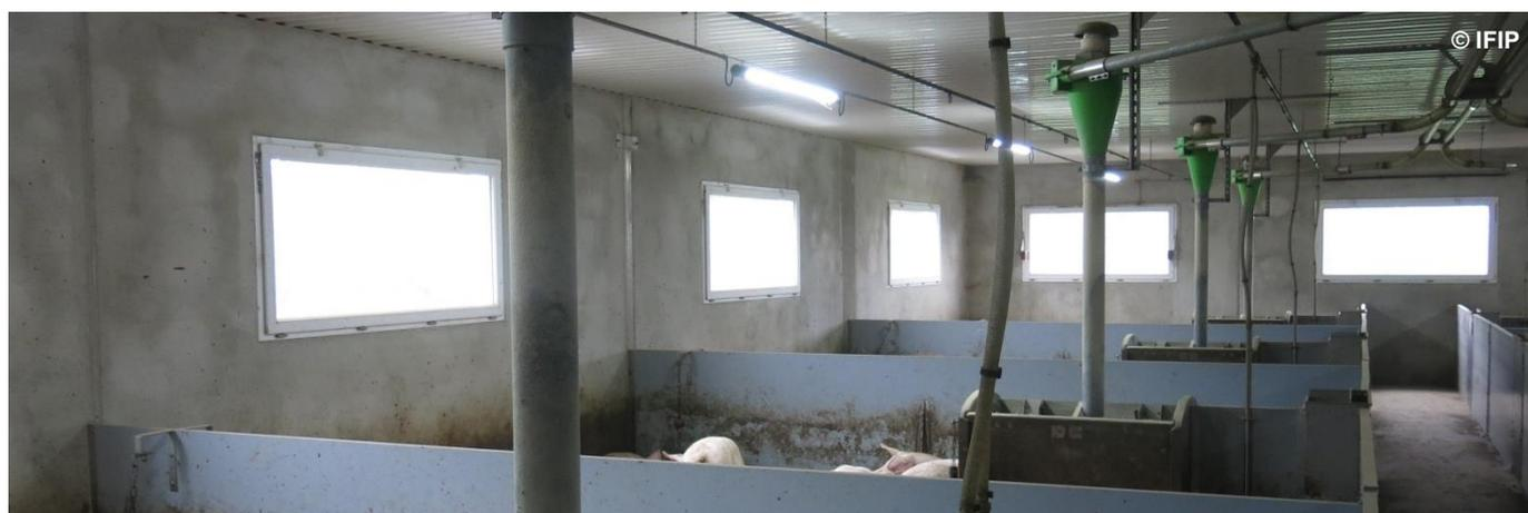
Avec des fenêtres de 2 m sur 1 m et une fenêtre par panneau béton, la quantité de lumière entrant dans les salles est très importante
