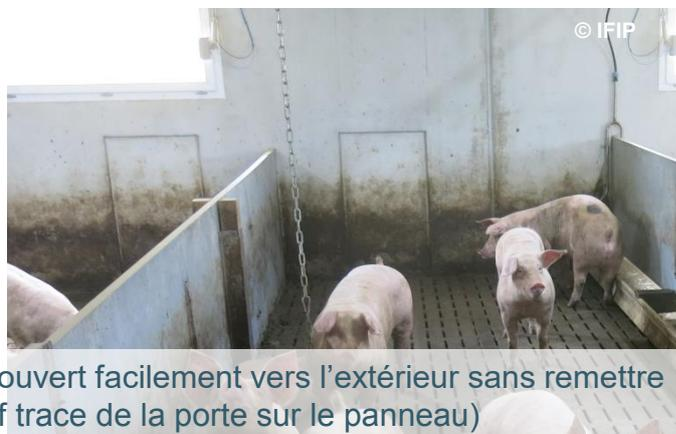
Installer des panneaux béton conçus pour être ouvert facilement vers l'extérieur sans remettre en cause la solidité de la coque (cf trace de la porte sur le panneau)
