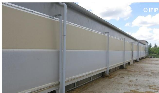
Gérer les entrées d'air avec des brises vent (filets, à gauche ou bâches pleines, à droite)
