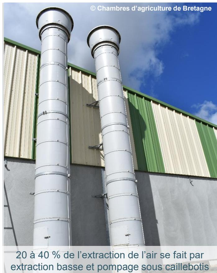
20 à 40 % de l'extraction de l'air se fait par extraction basse et pompage sous caillebotis
