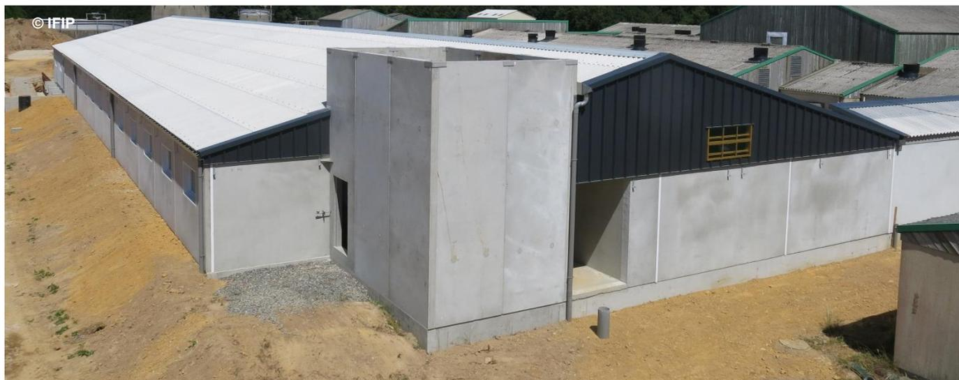
Canaliser l'air vicié des salles dans la gaine d'extraction d'une ventilation centralisée facilite l'installation d'un dispositif de récupération des calories de l'air
