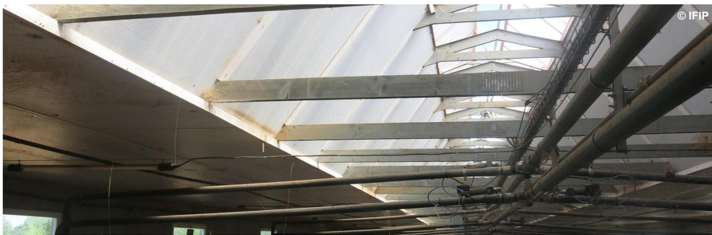
Associer un plafond plat et un faîtage en verrière pour jumeler une entrée de lumière importante et un circuit de ventilation correct
