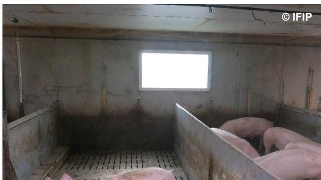
Positionner les fenêtres entre deux cases. Si besoin, elles seront transformées en portes pour permettre de sortir sur les courettes à venir tout en assurant un passage d'Homme.
