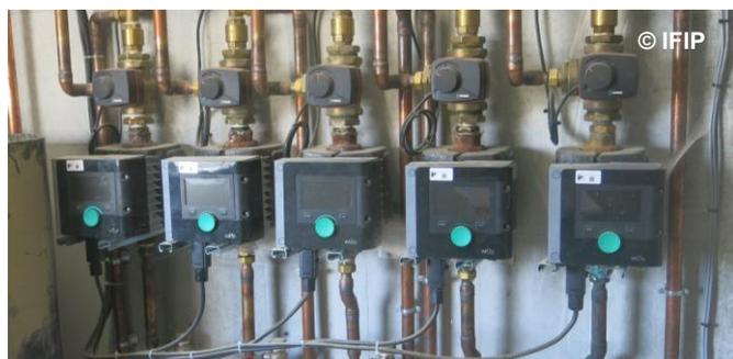
Installer des mitigeurs et des circulateurs pour gérer la température de la zone chauffée
