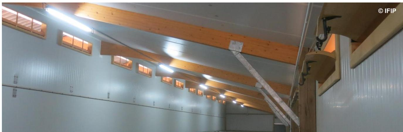
Piloter les volets d'entrée (à droite) et de sortie (à gauche) de l'air de manière synchrone pour obtenir un tirage d'air constant et homogène dans le temps
