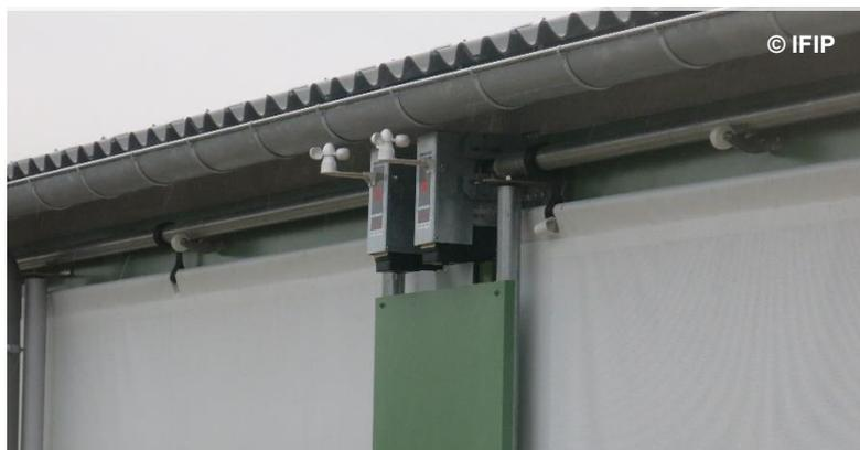
Piloter les entrées d'air motorisées selon la température dans le bâtiment mais aussi les aléas climatiques extérieurs (ici vitesse du vent)
