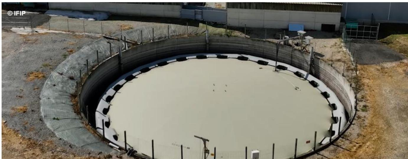
Couverture flottante de collecte du biogaz sur une fosse de 1200 m<sup>3</sup> de 24 m de diamètre
