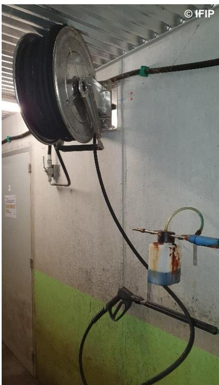
Installer un enrouleur automatique ou manuel du flexible du laveur haute pression
