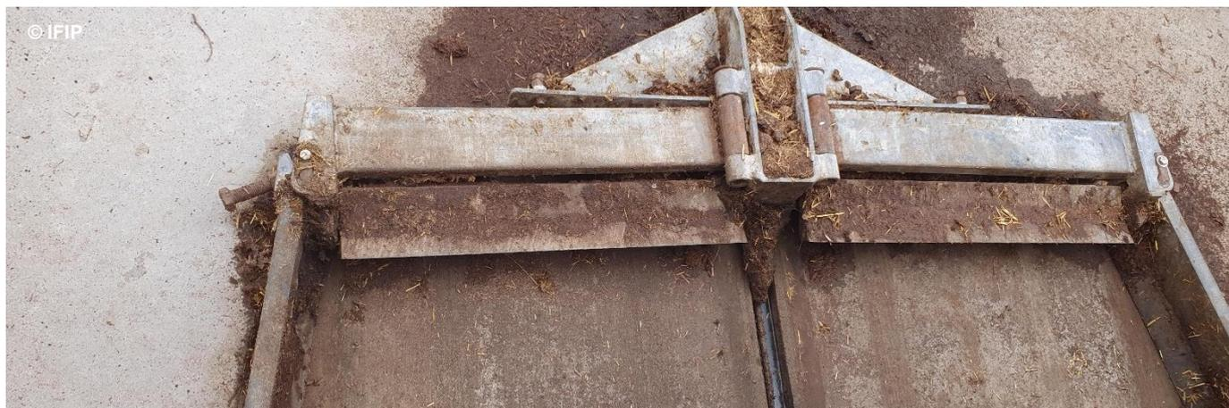
Racler sous caillebotis pour disposer de déjections fraîches au potentiel méthanogène élevé et éviter les émissions de gaz à effet de serre (GES) en bâtiment
