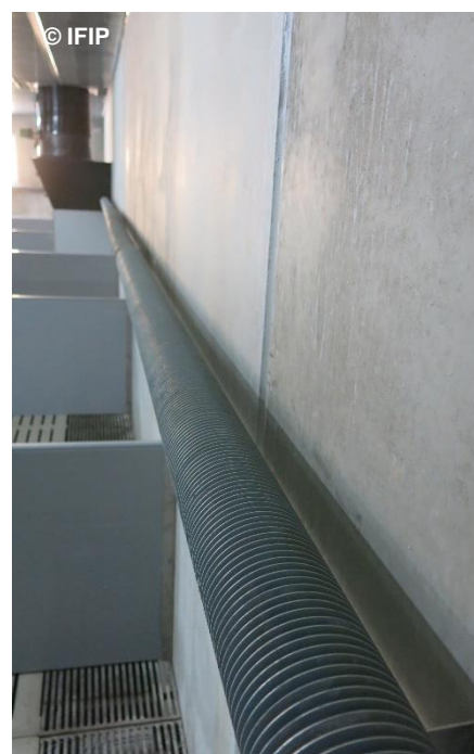
Aérotherme ou tube à ailette pour dissiper la chaleur dans les salles d'élevage
